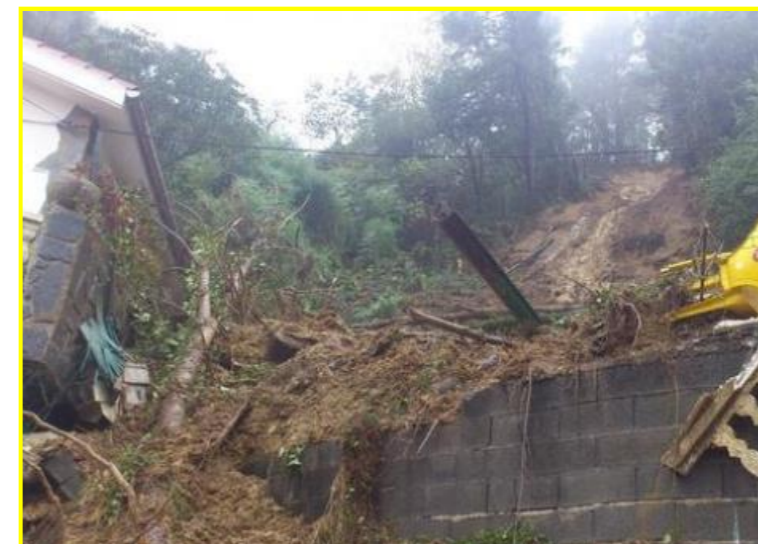
Desprendimiento en San Pedro
