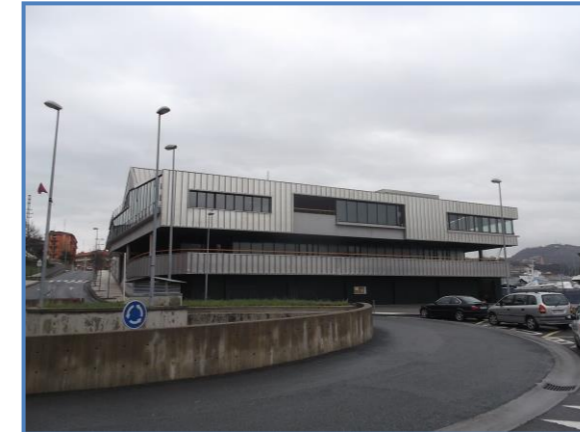
Edificio socio cultural de remo Donibane
