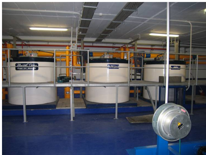
Foto 4: Edificio Pasaia (fábrica de hielo)
