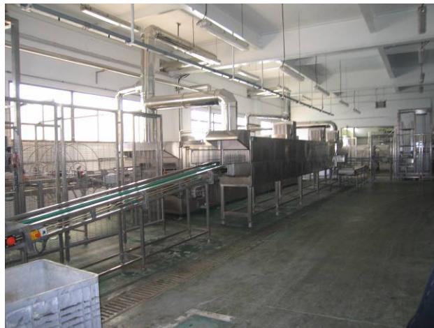
Foto 1: Túnel de lavado de cajas
