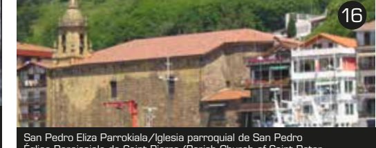
San Pedro Eliza Parrokiala/Iglesia parroquial de San Pedro/Eglise Paroissiale de Saint Pierre/Parish Church of Saint Peter
