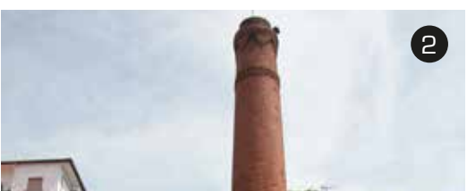
Portzelana Fabrikaren Tximinia/Chimenea de la Fábrica de Porcelanas/Cheminée de l'Usine de Porcelaines/Chimney of the Porcelain Factory
