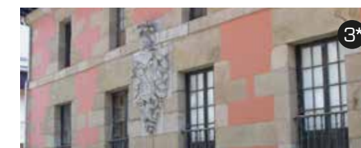
Arizabalo jauregia/Palacio Arizabalo/Palais Arizabalo/Arizabalo Mansion
